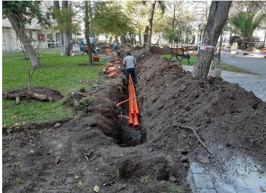
Fotografía 2: Nuevos ductos y cableado eléctrico subterráneo, en Casa Central.
